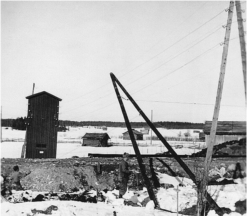
Ylhäällä: Olavi Isotalo (vas.) ja Jussi Luoma ovat valjastaneet A-pylvään pystyttämistä varten. Alla: Vinssien avulla uusi pylväs nousee korvaamaan vanhaa. Kuvat: Lyyli Asplundin kokoelmat
