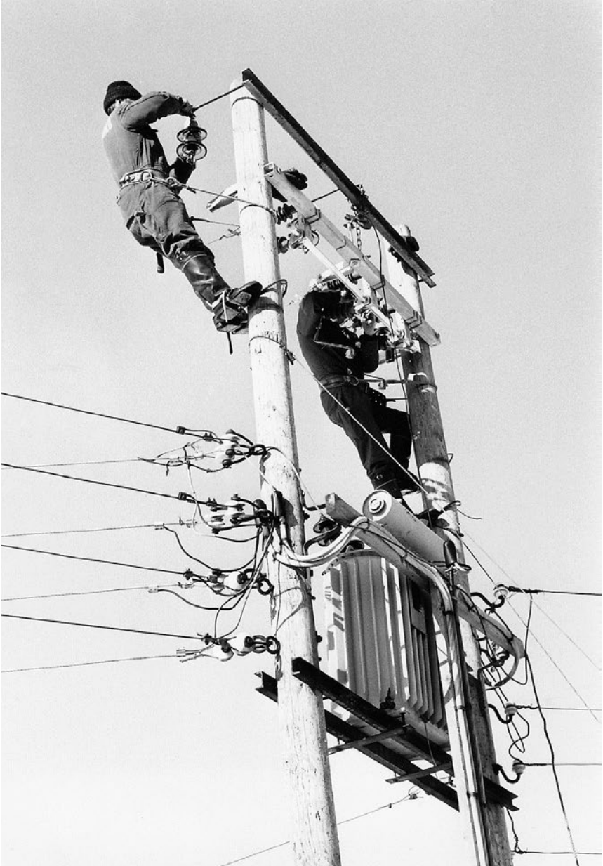
Ulkojohtoasentajien päätä ei saa huimata. Muuntajan asennustyö meneillään vuonna 1981. Kuva: Alajärven Sähkö Oy:n arkisto / Valokuvat
