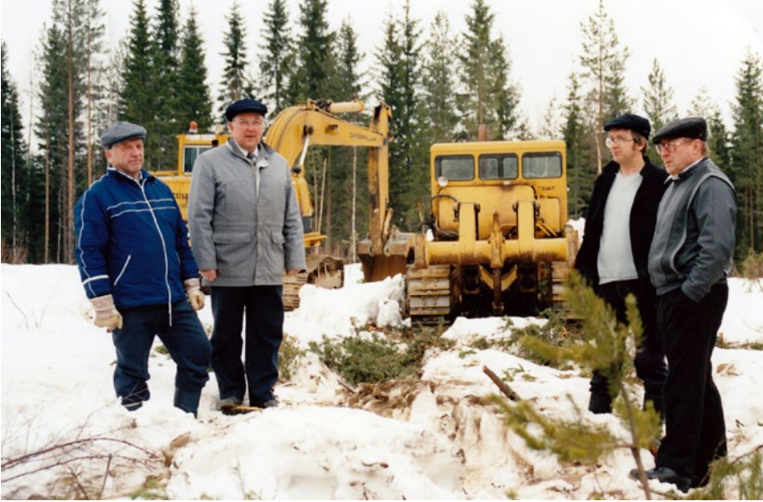
Hoiskon sähköaseman rakentaminen alkamassa, vas. Väinö Järvi, Esko Asplund, Markku Kariluoma ja Erkki Mäkelä. Kuva: Lyyli Asplundin kokoelmat
