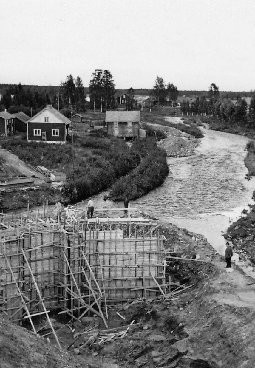
Yläpadon rakentaminen meneillään voimalaitokselle menevän kanavan alkupäässä, vas. Santeri Pienimäen talo ja Koskenniskan mylly. Kuva: Lyyli Asplundin kokoelmat
