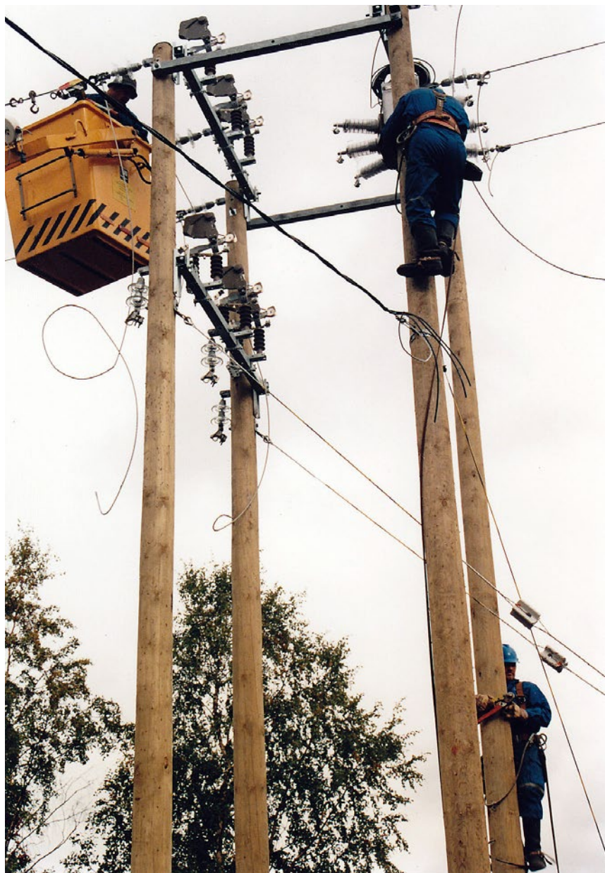
Kuoleman erotinasemaa rakennetaan, alimpana Mikko Mannila. Kuva: Alajärven Sähkö Oy:n arkisto / Valokuvat
