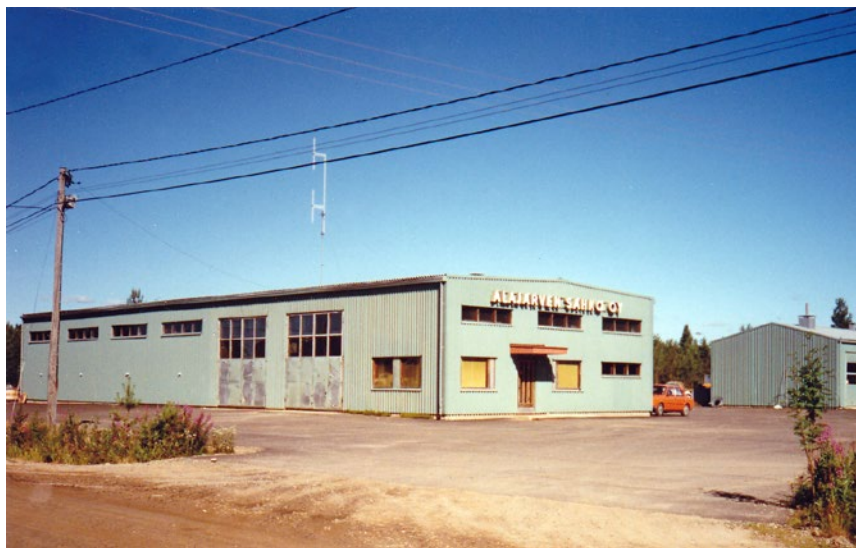
Alajärven Sähkö Oy:n hallit teollisuusalueella. Kuva: Lyyli Asplundin kokoelmat
