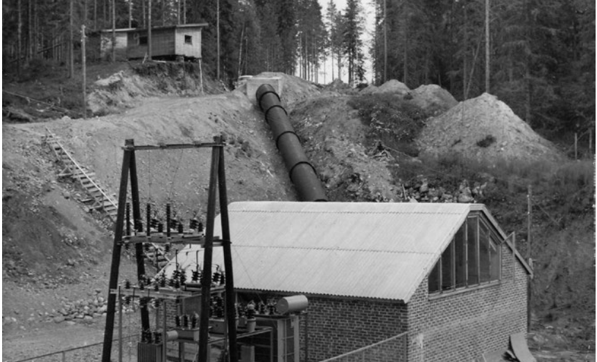
Koskenvarren voimalaitoksen tuloputki ennen peittämistä. Kuva: Alajärven Sähkö Oy:n arkisto / Valokuvat
