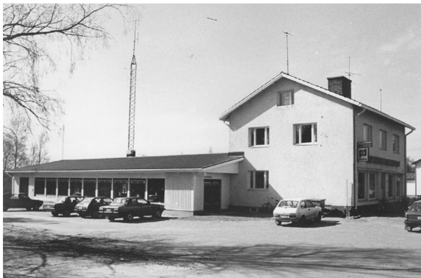
Vuoden 1983 laajennuksen pinta-ala oli noin 300 m 2 . Vanha osa jäi toimistotiloiksi. Kuva: Alajärven Sähkö Oy:n arkisto / Valokuvat
