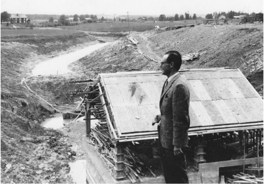
Hamilkar Aalto Koskenvarren voimalaitoksen rakennustyömaalla. Kuva: Lyyli Asplundin kokoelmat
